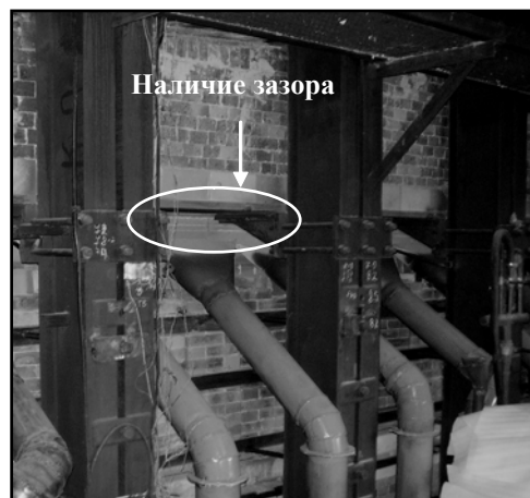
Рисунок 2 – Наличие зазора в кладке печи.
