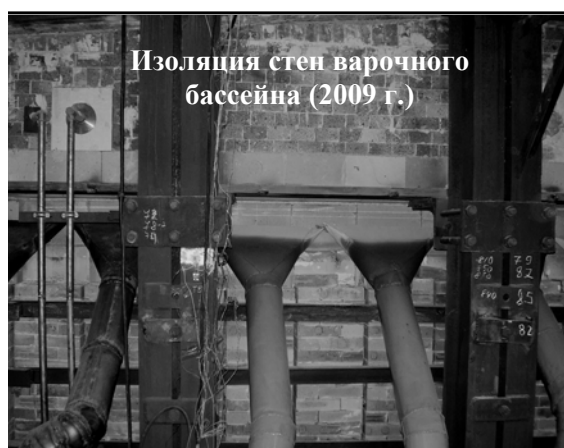
Рисунок 3 – Изоляция стен варочного бассейна в 2009 г.
