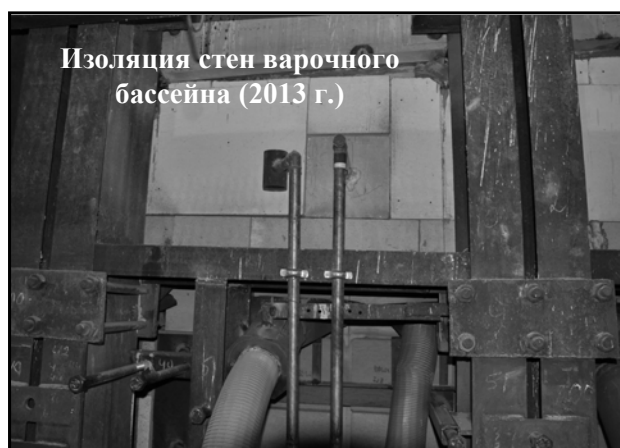
Рисунок 4 – Изоляция стен варочного бассейна в 2013 г.
