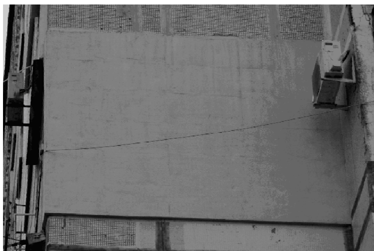
Рисунок 1 – Вид деформированных плит утеплителя.
