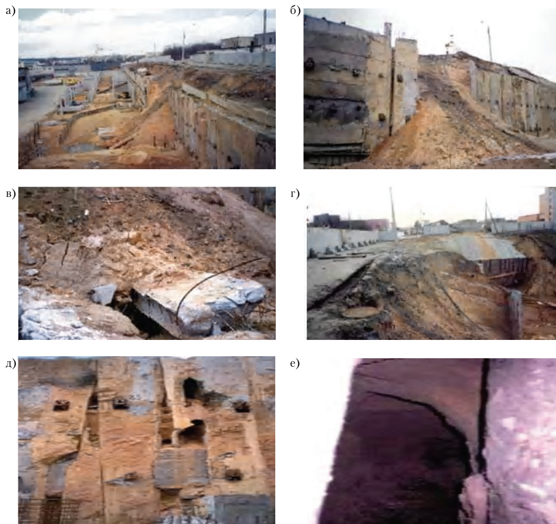
Рисунок 2 – Элементы подпорной стены после аварии: а) общий вид котлована; б) зона обрушения; в) обрушившаяся секция; г) канализационный люк возле зоны обрушения; д) дефекты бетонирования секций траншейных стен; е) суффозионная полость в зазоре между секциями.
