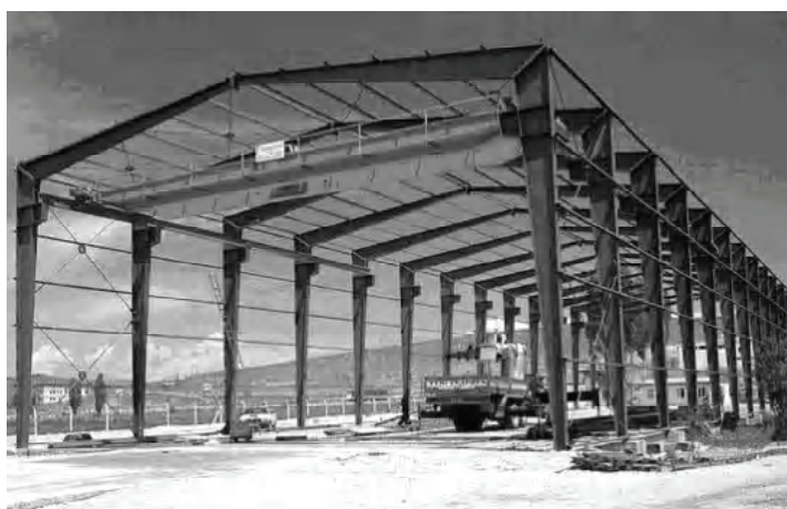
Рисунок 2 – Перекрытие на основе рам
