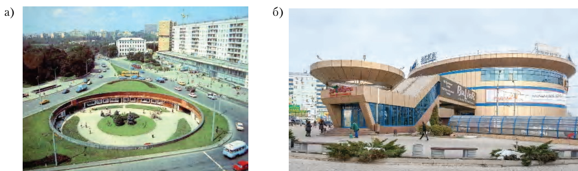
Рисунок 5 – Использование пространства для устройства заглубленной части подземного перехода (2001 г., ТРЦ «Среда») на пл. Коммунаров в городе Донецк: а) подземный переход с торговыми киосками (до реконструкции); б) общий вид ТРЦ (после реконструкции).
