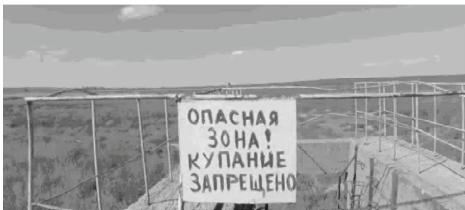
Рисунок 9 – Современное состояние водохранилища.
