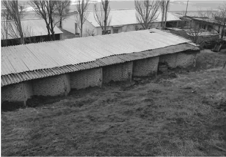
Рисунок 5 – Наплыв грунта на спальные домики типа «елочка».
