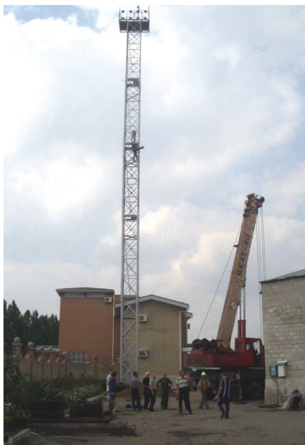
Рисунок 2 – Общий вид смонтированной антенной опоры АО-35.
