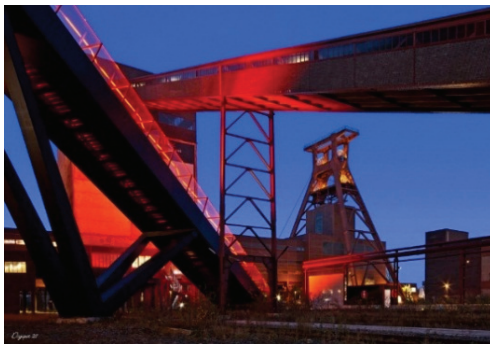
Рисунок 1 – Общий вид общественно-культурного центра на территории действующей шахты «Цольферайн» в г. Эссен (Германия).
