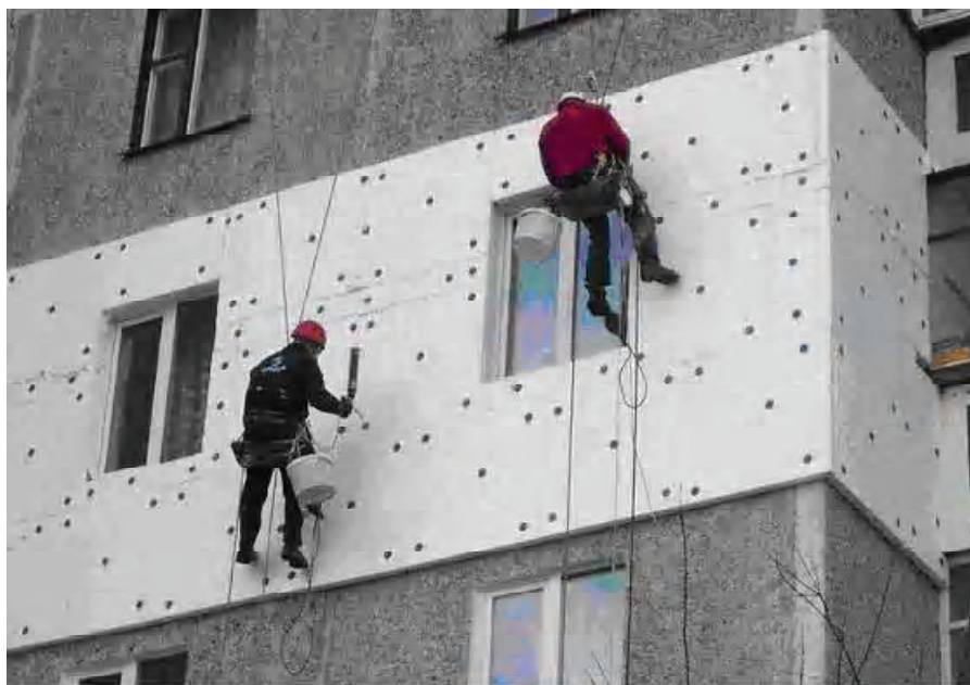
Рисунок – Выполнение работ по повышению теплозащиты отдельной квартиры крупнопанельного дома.
