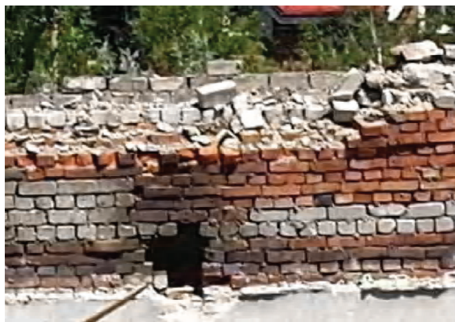
Рисунок 3 – Фрагмент кладки стены по оси 7.
