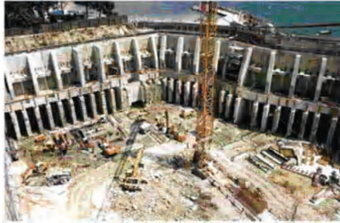
Рисунок 1 – Устройство ограждающих конструкций котлованов с контрфорсами [4].
