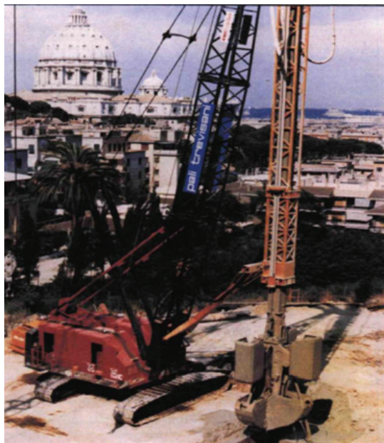
Рисунок 5 – Трехчелюстной грейфер фирмы «SOILMEC» [4].
