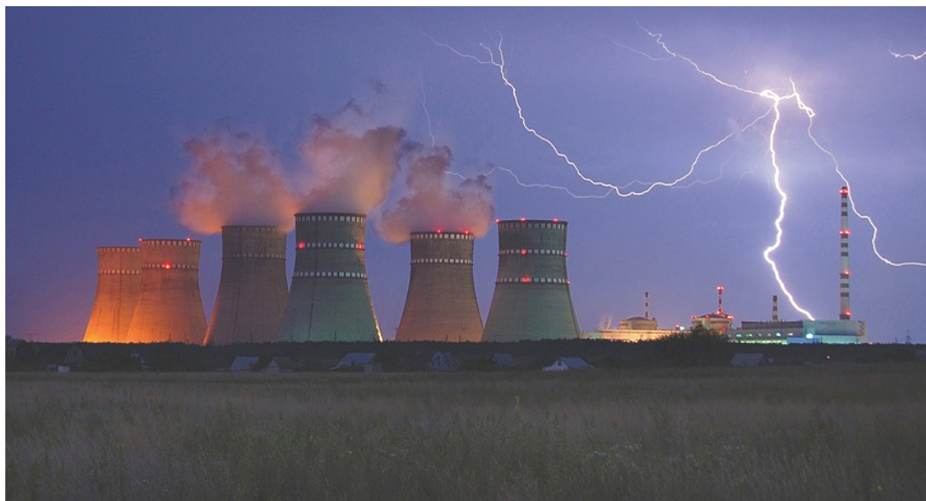
Рисунок 5 – НАЧАЛО «СВЕРХ-ВЫСОТЫ»: градирни высотой 150 метров Ровенской АЭС, бывший гор. Кузнецовск, Западная Украина, первые «СВЕРХВЫСОТНЫЕ» и «САМЫЕ ПЕРВЫЕ» в СССР, градирня – гиперболический параболоид, 1977 год. Всепогодное круглогодичное строительство огромных 150-метровых осободолговечных башенных железобетонных градирен с применением лигносуфоалюминатов ЛТМ. Это ещё одно доказательство отечественных высших научно-технических достижений XX века. Потом возводили такие же градирни на Ново-Ангренской ГРЭС в Узбекистане. Проект: Б. Д. Тринкер. Автор бетона: А. Б. Тринкер.
