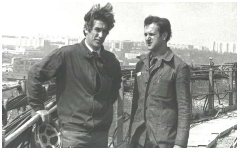
Рисунок 4 – На палубе скользящей опалубки градирни ТЭЦ-25 Мосэнерго (Очаково), справа главный технолог А. Б. Тринкер, слева директор станции, 1977 год.
