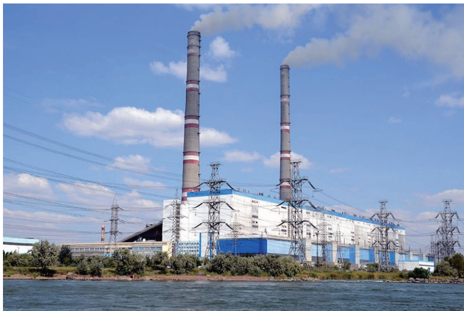
Рисунок 2 – Самые высокие в Азии дымовые трубы по 330 метров, Экибастузская ГРЭС № 1, мощностью 4 млн квт., 1979 год.
