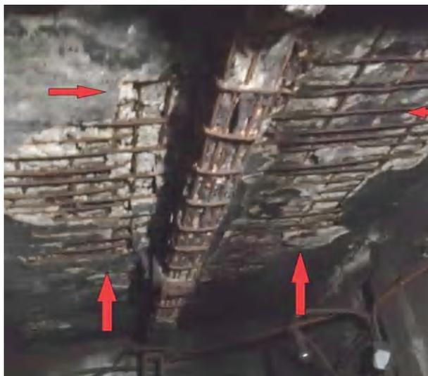
**Рисунок** – Фрагмент железобетонного перекрытия с поврежденным бетоном и коррозией арматуры.
