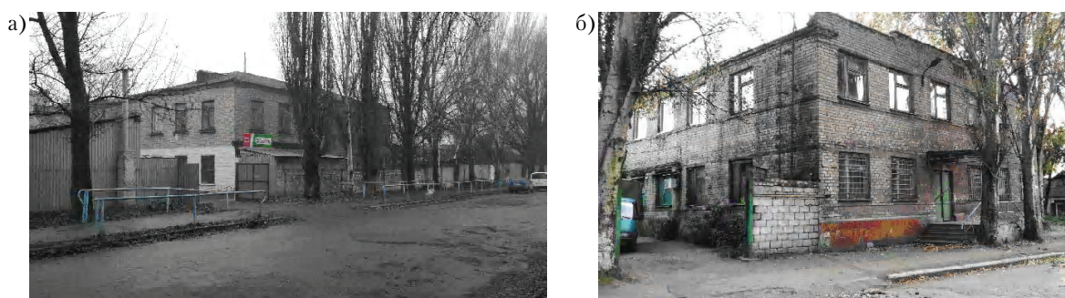
Рисунок 1 – Нынешнее состояние основных производственных корпусов Макеевского учебно-производственного предприятия УТОС: а) производственный корпус № 1; б) производственный корпус № 2 (фото авторов, 2017 г.)
