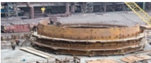
Рисунок 7 – Реконструкция доменной печи.
