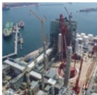
Рисунок 13 – Демонтаж колонн нефтеперерабатывающего предприятия.
