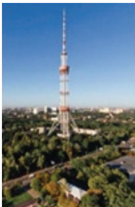
Рисунок 9 – Монтаж телевизионной башни методом подрачивания с помощью гидравлического подъемника (г. Киев).
