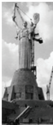
Рисунок 10 – Прислонный вариант крепления башни крана БК-1000 к конструкции памятника «Родина-мать» методом подрачивания (г. Киев).
