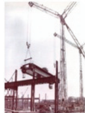
Рисунок 8 – Монтаж укрупненных пространственных блоков.
