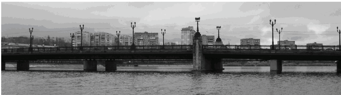
Рисунок 1 – Общий вид реконструируемого моста.
