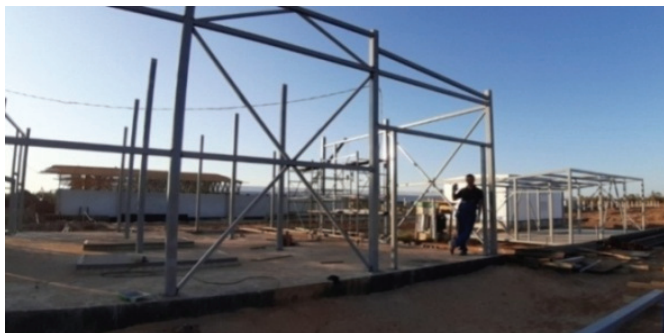
Рисунок 1 – Жесткий блок металлического каркаса здания котельной.
