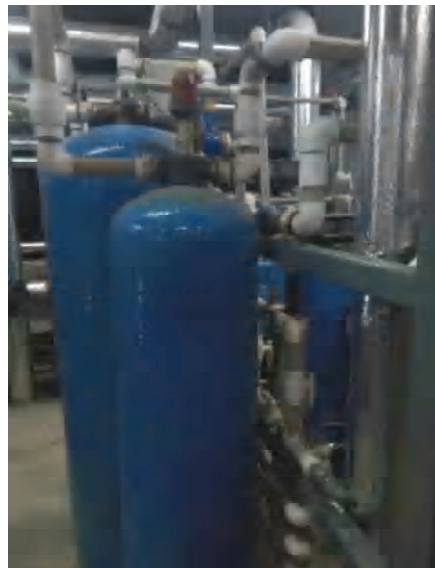
Рисунок 8 – Пусконаладочные работы в котельной.
