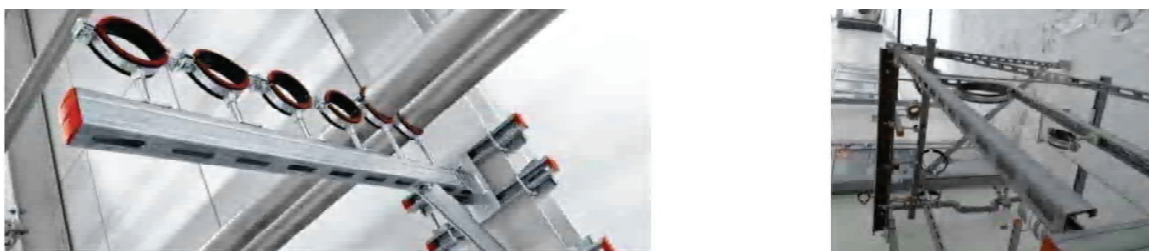
Рисунок 4 – Примеры соединений профилей для крепления трубопроводов.
