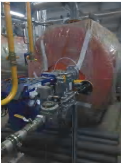
Рисунок 7 – Монтаж оборудования котельной с помощью роликовых катков.
