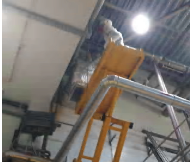
Рисунок 6 – Крепление, стыковка технологических трубопроводов с помощью подъемника.
