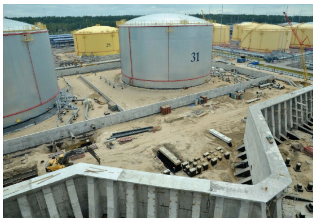
Рисунок 5 – Устройство монолитного железобетонного ограждения каре.
