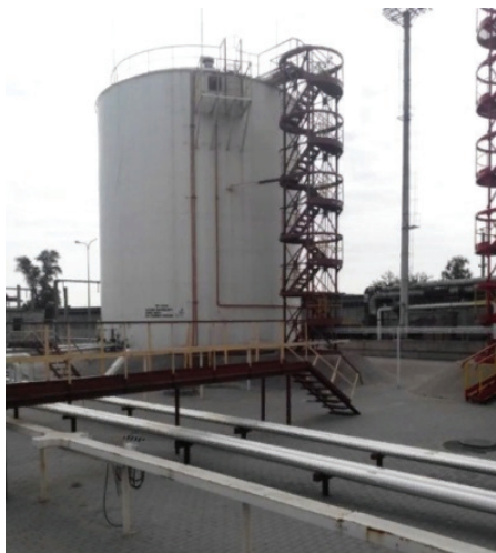
Рисунок 4 – Ограждающий слой пола каре из тротуарной плитки.
