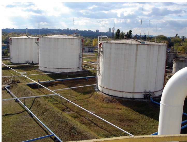
Рисунок 6 – Устройство земляного защитного слоя и обвалования.
