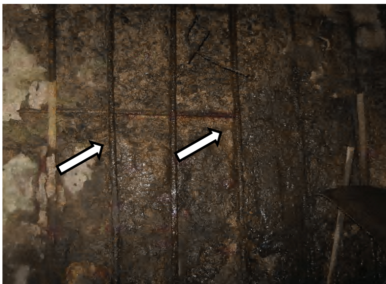
Рисунок 5 – Участки разрушения защитного слоя бетона глубиной до 40 мм в местах протечек с обнажением и коррозионным износом рабочей арматуры до 10 % поперечного сечения.
