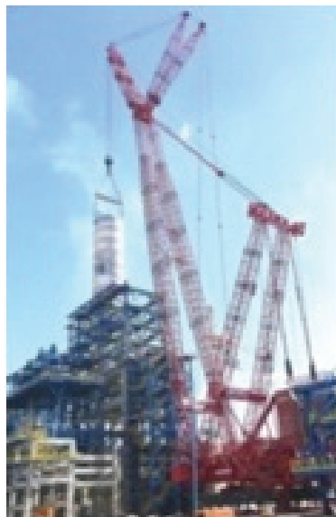
Рисунок 17 – Монтаж коксовой камеры установки замедленного коксования.
