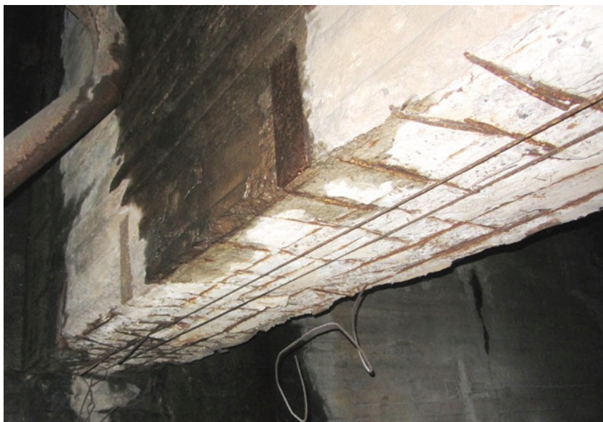
Рисунок 7 – Недостаточный защитный слой бетона на поверхностях балки перекрытия с обнажением и коррозией рабочей арматуры до 10...15 % поперечного сечения.
