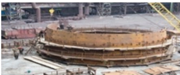
Рисунок 7 – Реконструкция доменной печи.
