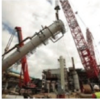
Рисунок 16 – Установка новой колонны для синтеза аммиака.
