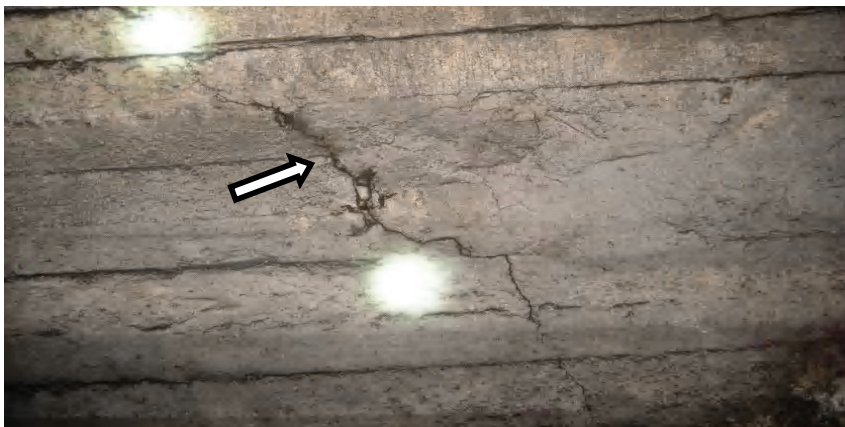
Рисунок 6 – Вертикальные и наклонные трещины в конструкциях несущих стен шириной раскрытия до 0,4 мм.
