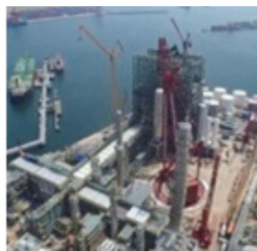
Рисунок 13 – Демонтаж колонн нефтеперерабатывающего предприятия.
