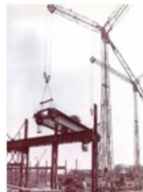
Рисунок 8 – Монтаж укрупненных пространственных блоков.
