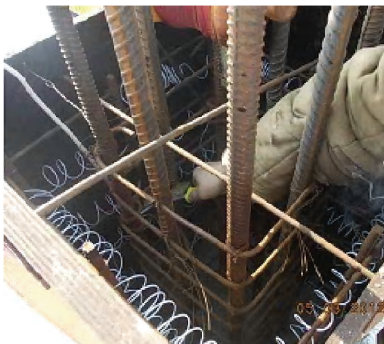
Рисунок 1 – Установка греющего провода путем навивки его на арматуру.
