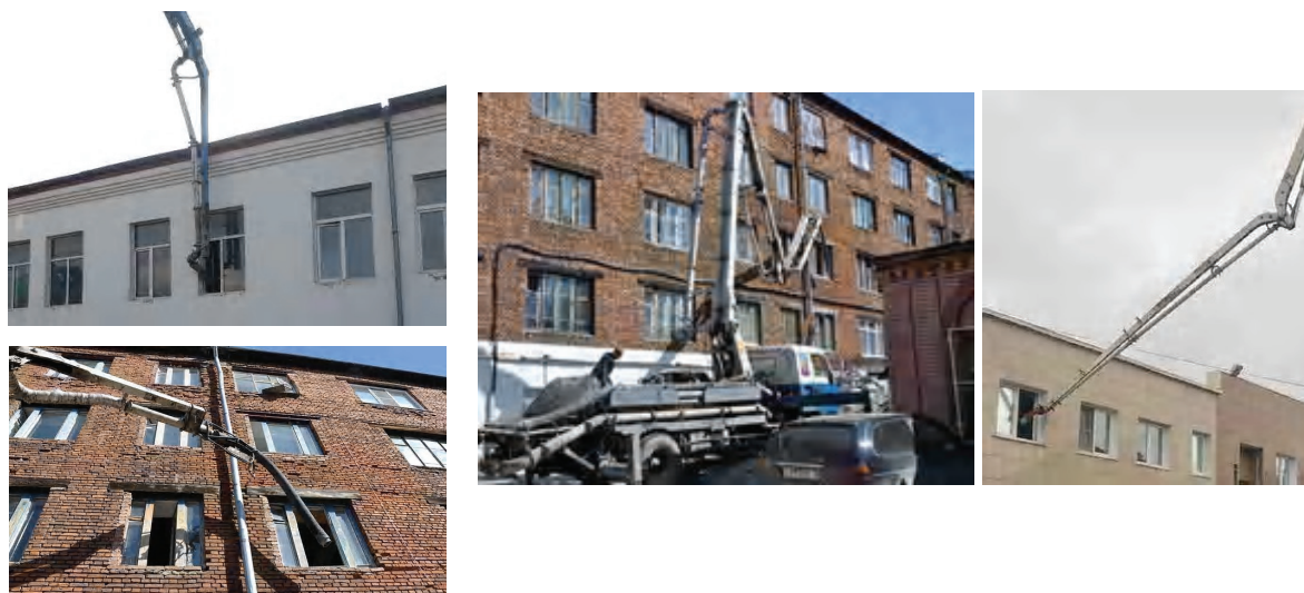
Рисунок 8 – Подача бетонной смеси автобетононасосом через оконный проем.
