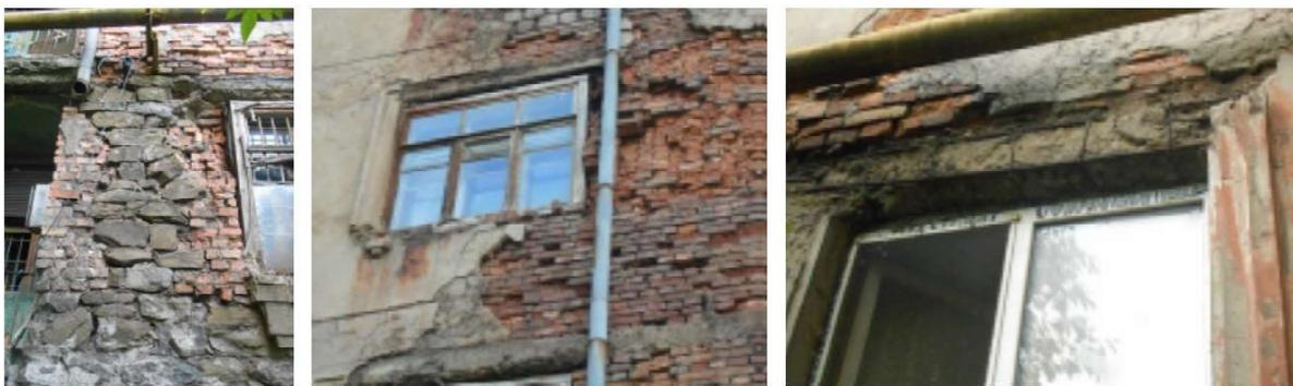
Рисунок 3 – Повреждения кирпичных стен и перемычек.
