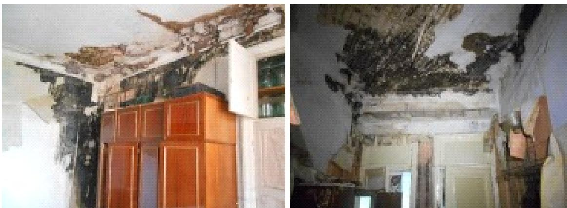
Рисунок 4 – Следы протечек кровли.
