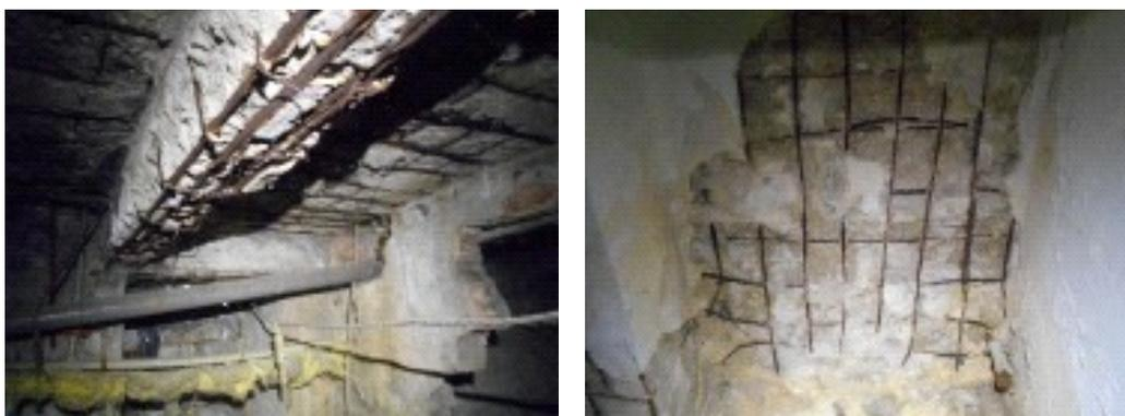
Рисунок 5 – Повреждения и деформации железобетонных балок и перекрытий.
