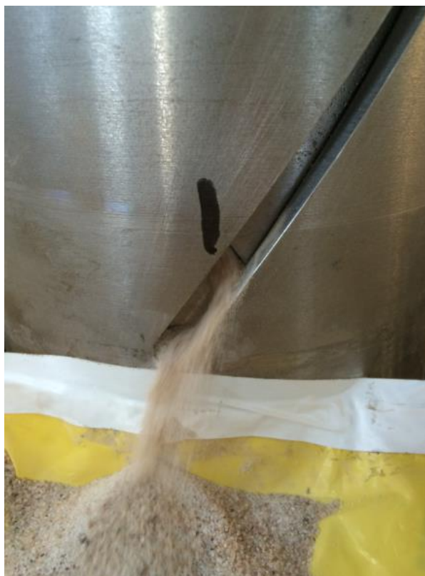
Рис. 2.13. Извлечение необходимого количества песка из устройства для регулирования геометрического положения здания в пространстве.
